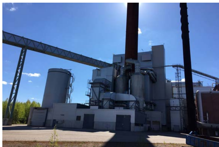
Am Fluss Kymijoki in der finnischen Stadt Myllykoski liegt das stillgelegte Kraftwerk (Markierung), das früher die ebenfalls geschlossene Papierfabrik mit Prozessdampf versorgt hat (l.). Rund 2000 Tonnen, zumeist Stahl, werden abgebaut und nach Knapsack transportiert (r.).
