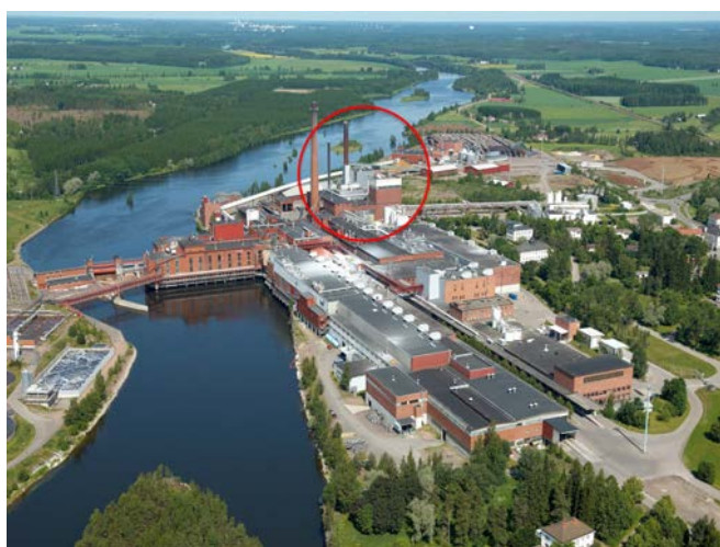
Am Fluss Kymijoki in der finnischen Stadt Myllykoski liegt das stillgelegte Kraftwerk (Markierung), das früher die ebenfalls geschlossene Papierfabrik mit Prozessdampf versorgt hat (l.). Rund 2000 Tonnen, zumeist Stahl, werden abgebaut und nach Knapsack transportiert (r.).
