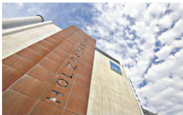
Noch prangt das SWU-Logo auf dem Kraftwerk. Foto: Oliver Schulz
